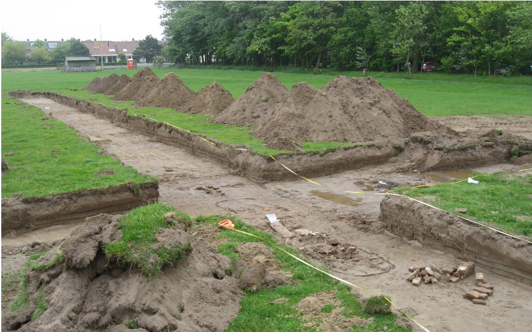
Bijlage 3.1 Overzichtsfoto kruising proefsleuf 1 met proefsleuf 3 op de strandwal. Op de voorgrond de 'uitbraaksleuven' van spoor 27 t/m 30. Zicht naar het noordoosten.
